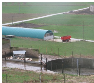
© DDEA du Jura, stockage des effluents.
