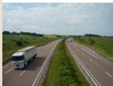
Autoroute A39. © DDT du Jura, J-L. Gomez.
