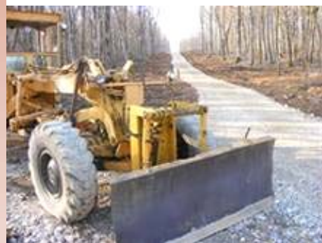
Construction d'une route forestière. © CRPF. François Lacroix.
