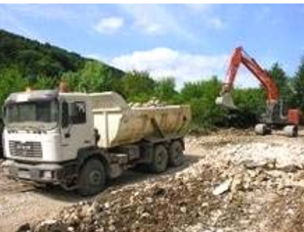
Construction d'une route forestière. © CRPF. François Lacroix.
