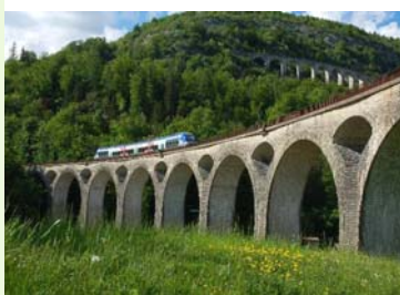
Viaducs à Morez. © PNRHJ. J. Carrot.
