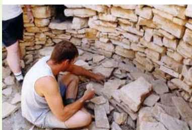
Chantier de réinsertion. © « Agate paysages ».
