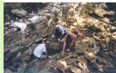
Chantier de réinsertion. © « Agate paysages ».
