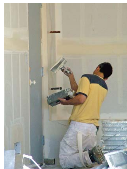
Anah : travaux intérieurs. © prêt : « JURA Habitat ».
