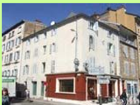
Lons-le-Saunier : travaux aidés par l'Anah. © prêt : ECLA.
