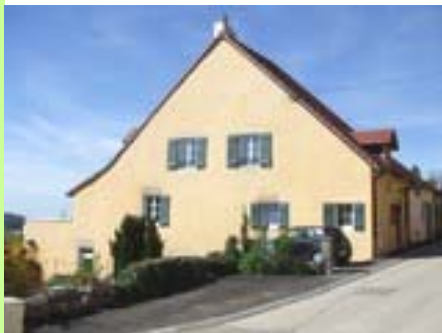
Perrigny : travaux aidés par l'Anah. © prêt : ECLA.
