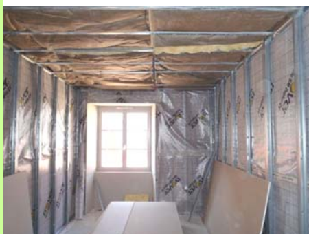
Pannessières : travaux aidés par l'Anah. © prêt : ECLA.
