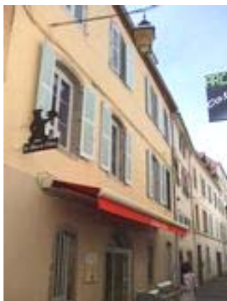
Lons-le-Saunier : travaux aidés par l'Anah. © prêt : ECLA.
