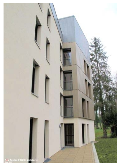
OPH du Jura : construction neuve (rue Schuman à Lons-le-Saunier). © Agence Frédéric Bois.
