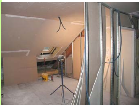
Anah : isolation des combles. © prêt : « JURA Habitat ».
