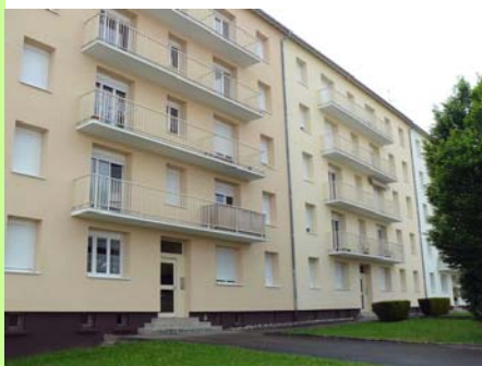
OPH du Jura : travaux boulevard Duparchy à Lons-le-Saunier. © OPH du Jura.
