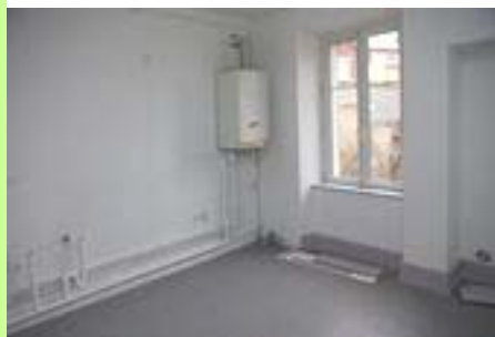
Travaux aidés par l'Anah. © prêt : Anah.
