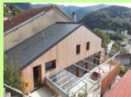
Réhabilitation BBC : maison Effilogis à Saint-Claude. © ADEME.
