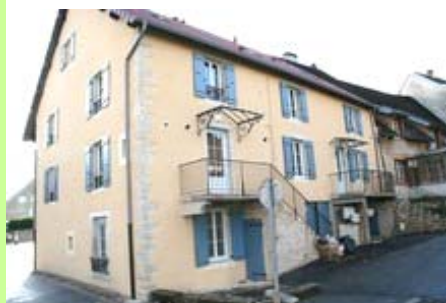
Messia-sur-Sorne : travaux aidés par l'Anah. © prêt : ECLA.
