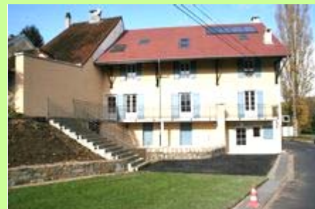
Messia-sur-Sorne : réhabilitation. © prêt : ECLA.
