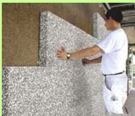
Isolation par l'extérieur. © prêt : « JURA Habitat ».
