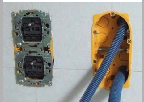
Électricité : blocs étanches à l'air. © Prêt : Laurent Boiteux.
