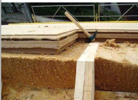
Isolation de la toiture. © Prêt : Laurent Boiteux.
