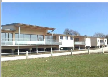
Pôle de l'enfance à Fraisans. © Thierry Barreau, architecte.
