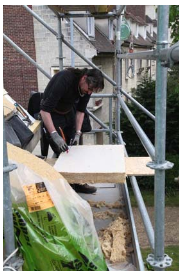
Isolation : découpe des matériaux. © Prêt : CAPEB.
