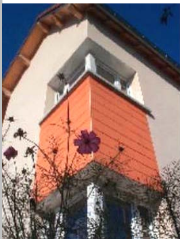
Éco-construction. © Prêt : Laurent Boiteux.
