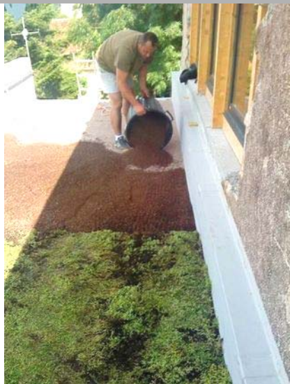
Toiture végétale. © Prêt : Laurent Boiteux.
