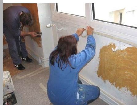
Formation « STUCCO » : équipe de stagiaires. © Prêt : CAPEB.
