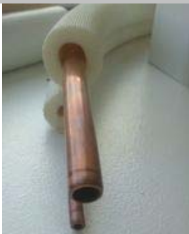
Isolation des réseaux. © Prêt : Laurent Boiteux.
