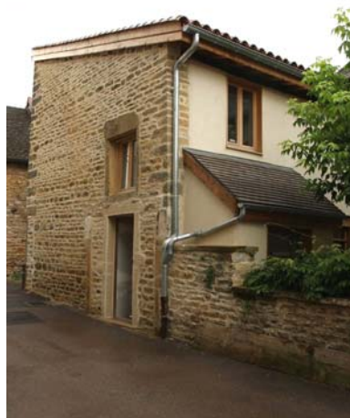
Pierres jointoyées à la chaux. © Prêt : CAPEB.
