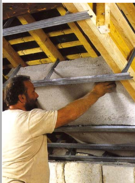
Isolation renforcée de la toiture. © Prêt : « JURA Habitat ».
