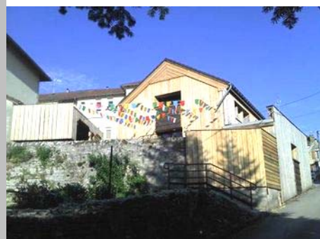
Éco-construction : bardage en bois. © Prêt : Laurent Boiteux.
