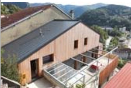
Réhabilitation BBC : maison Effilogis à Saint-Claude. © ADEME.
