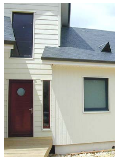
Maison à ossature bois. © Prêt : CAPEB.
