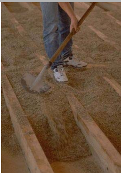
Isolation des plafonds. © Prêt : Laurent Boiteux.
