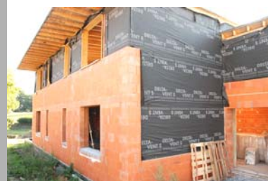
Gros œuvre : briques « Monomur ». © Prêt : CAPEB.
