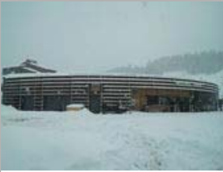
La Serra : bâtiment d'accueil des skieurs. Genevoux, architecture. © Prêt : CROA.
