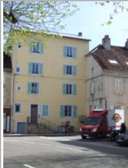
Réhabilitation à Lons-le-Saunier. © Prêt : ECLA.
