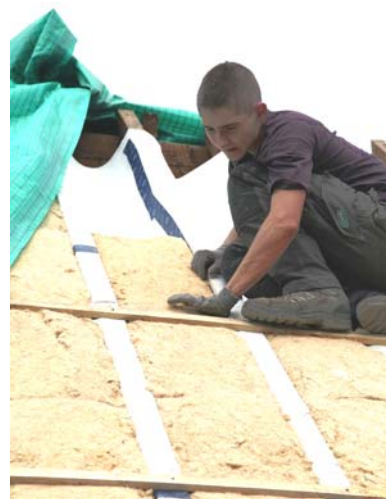
Toiture : isolation. © Prêt : CAPEB.
