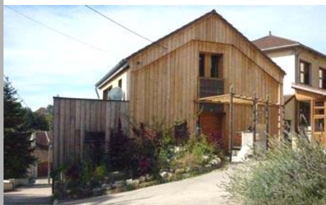
Éco-construction : bardage en bois. © Prêt : Laurent Boiteux.
