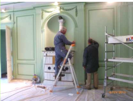
Le musée Sarret de Grozon : travaux. © Philippe Bruniaux.
