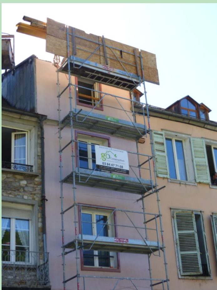
Une façade en cours de ravalement. © Sabine Mahut.
