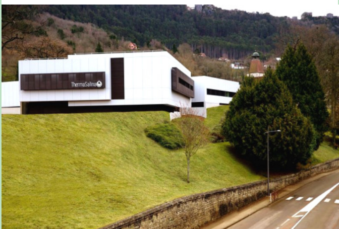
Le nouvel établissement thermal. © Ville de Salins-les-Bains.
