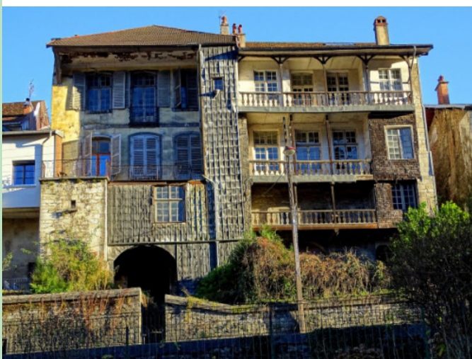
Un immeuble dégradé à rénover. © Claudette Bach.
