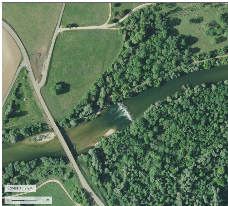
Figure 11 : Vue aérienne de l'ouvrage en aval du site sur la Loue
