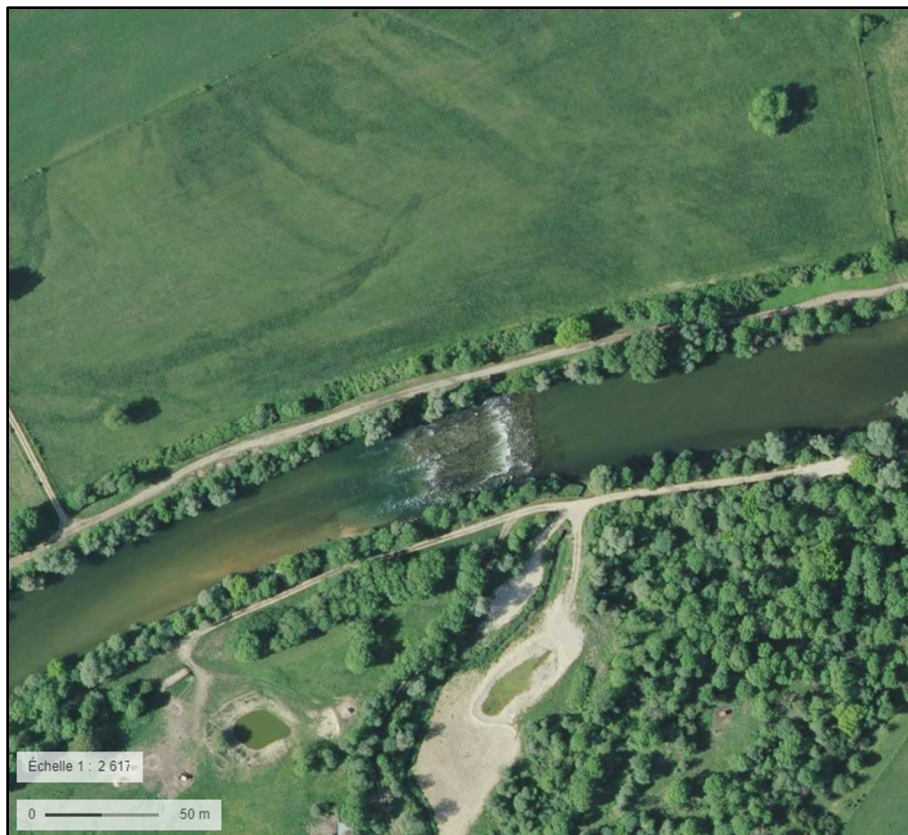
Figure 10 : Vue aérienne de l'ouvrage en amont du site sur la Loue
