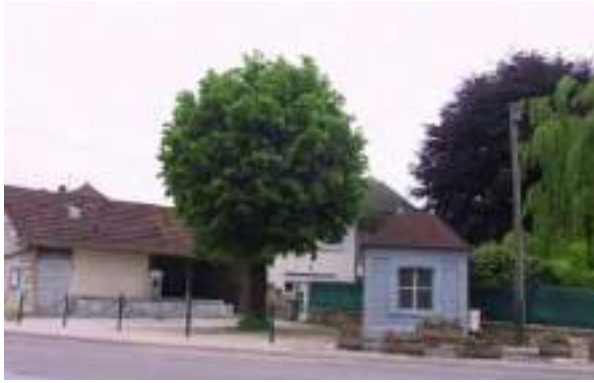
ELEMENT BATI N°8 : Bascule et maisonnette : Intersection rue du Lavoir/rue Edgard Faure
