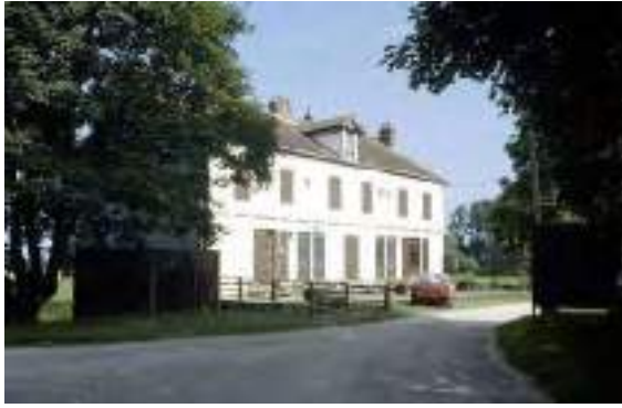
ELEMENT BATI N°1 : Moulin à blé, centrale hydroélectrique
