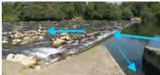
Seuil et échanture barrage latéral (2018)
