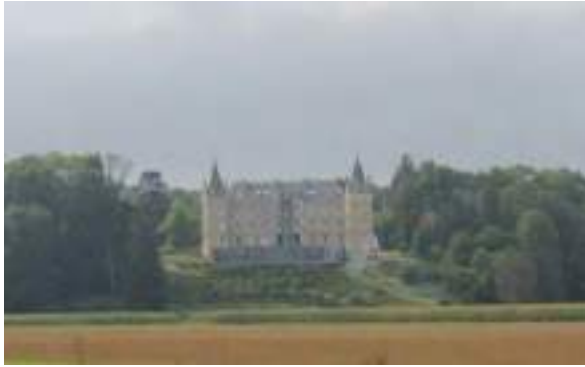
ELEMENT BATI N°1 : Château de Clairvans : façade depuis la D472 (toiture, tourelles)
