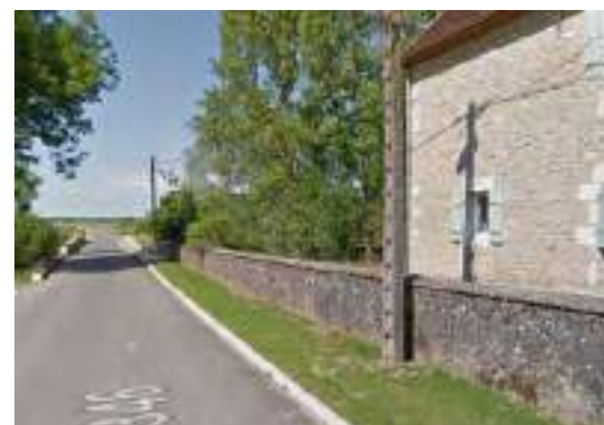
LINEAIRE A : Muret pierre
