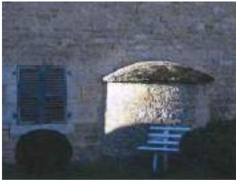
ELEMENT BATI N°2 : Four à pain sur ancienne ferme : Intersection Grande rue/rue des Fossés du Sud
