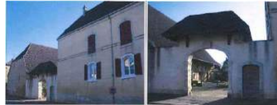
Façades et portail n° 13 Détail portail n° 13 ELEMENT BATI N°18 : Façade et portail : 44 Grande Rue
