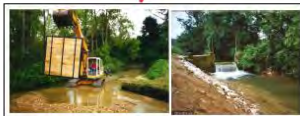
Travaux de remplacement de la « porte vanne » en 2000
