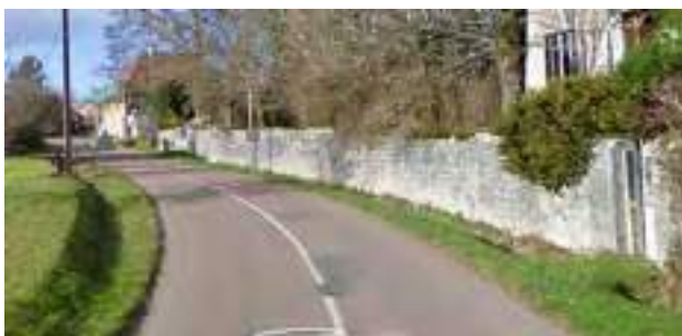
LINEAIRE A : Mur pierre : 11 rue de la Chapelle
