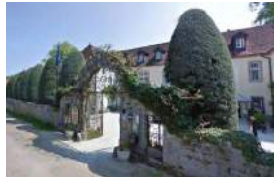
ELEMENT BATI N°3 : Château de Germigny (mur pierre, toiture/façade) : 21 rue Edgar Faure
