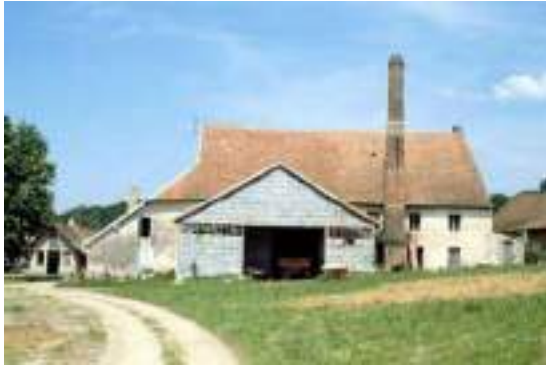
ELEMENT BATI N°1 : Usine de flaconnage dite verrerie de la Vieille Loye : chemin de la verrerie
