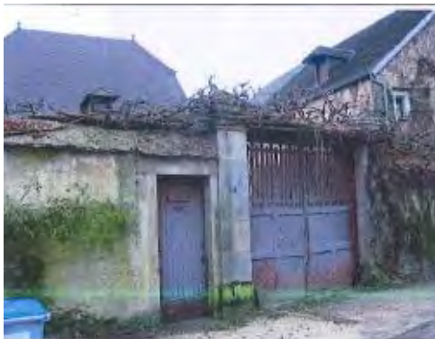
ELEMENT BATI N°22 : Portail et mur côté sud : rue du bas de la Fin/quartier du Port
