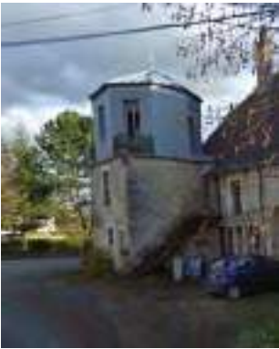
ELEMENT BATI N°2 : Toiture et pignon en bardage métallique: 16 rue du Pont / rue du Stade
