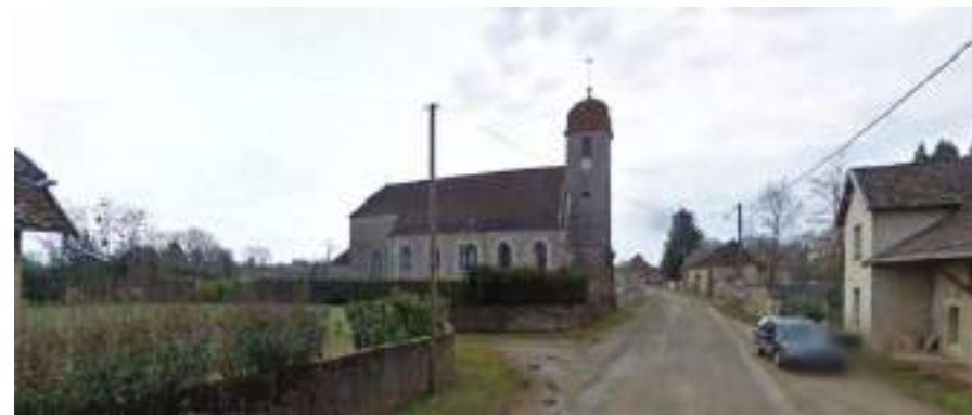
CONE DE VUE N°1 constructions en front bâti
