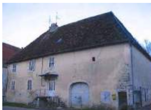
ELEMENT BATI N°2 : Ancien presbytère
