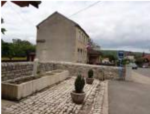
ELEMENT BATI N°3 : Fontaine : à côté de la mairie
