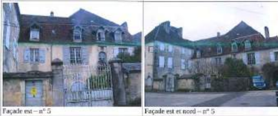
ELEMENT BATI N°20 : Demeure façade (EST, Nord, Ouest) : rue du bas de la Fin/quartier du Port
