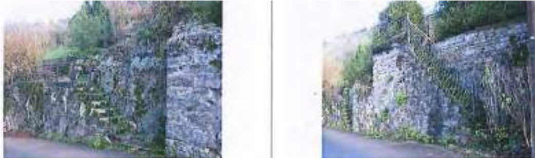
ELEMENT BATI N°27 : Escalier en pierre : rue du Coin du Four
