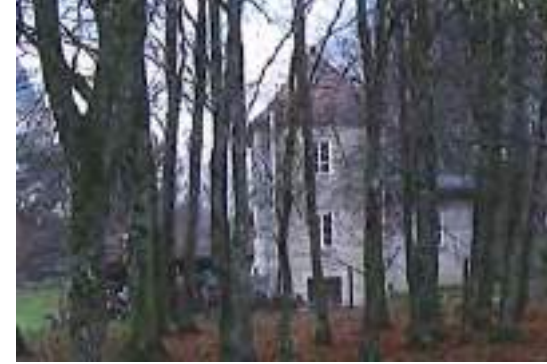
ELEMENT BATI N°2 et 3 : Un des deux pavillons à
