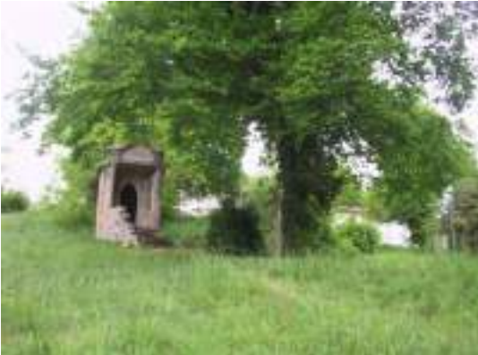
ELEMENT BATI N°31 : Chapelle : chemin de Bauquet
