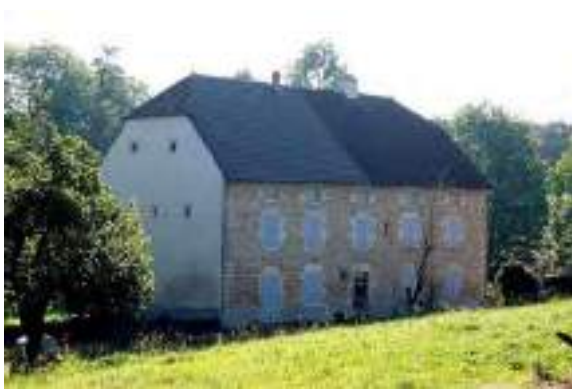
ELEMENT BATI N°1 : Fonderie, usine de chaudronnerie « la Forge » : rue du Moulin
