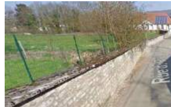
LINEAIRE B : Mur en pierre en bordure de route
