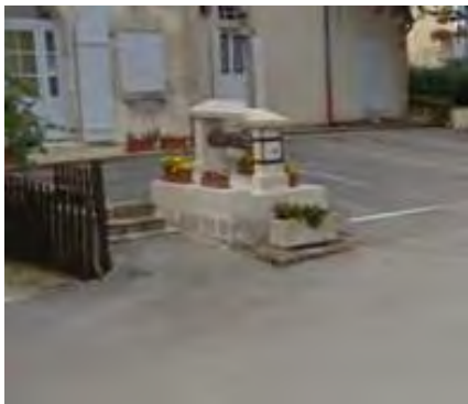
ELEMENT BATI N°2 : Puits en pierre
