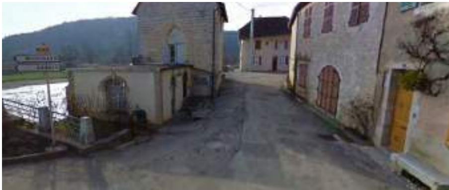
ELEMENT BATI N°13 : Ancienne chapelle : rue du Port
