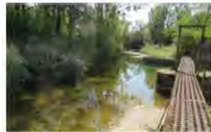
Ancien barrage passerelle (2018)
