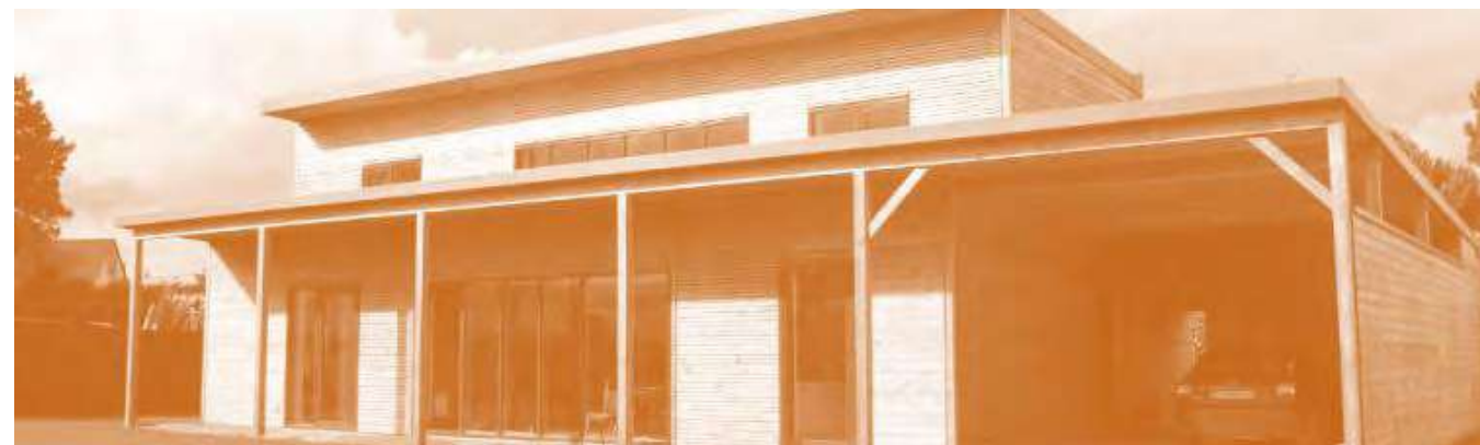
n étage construit en attique, Chantepie (35)
