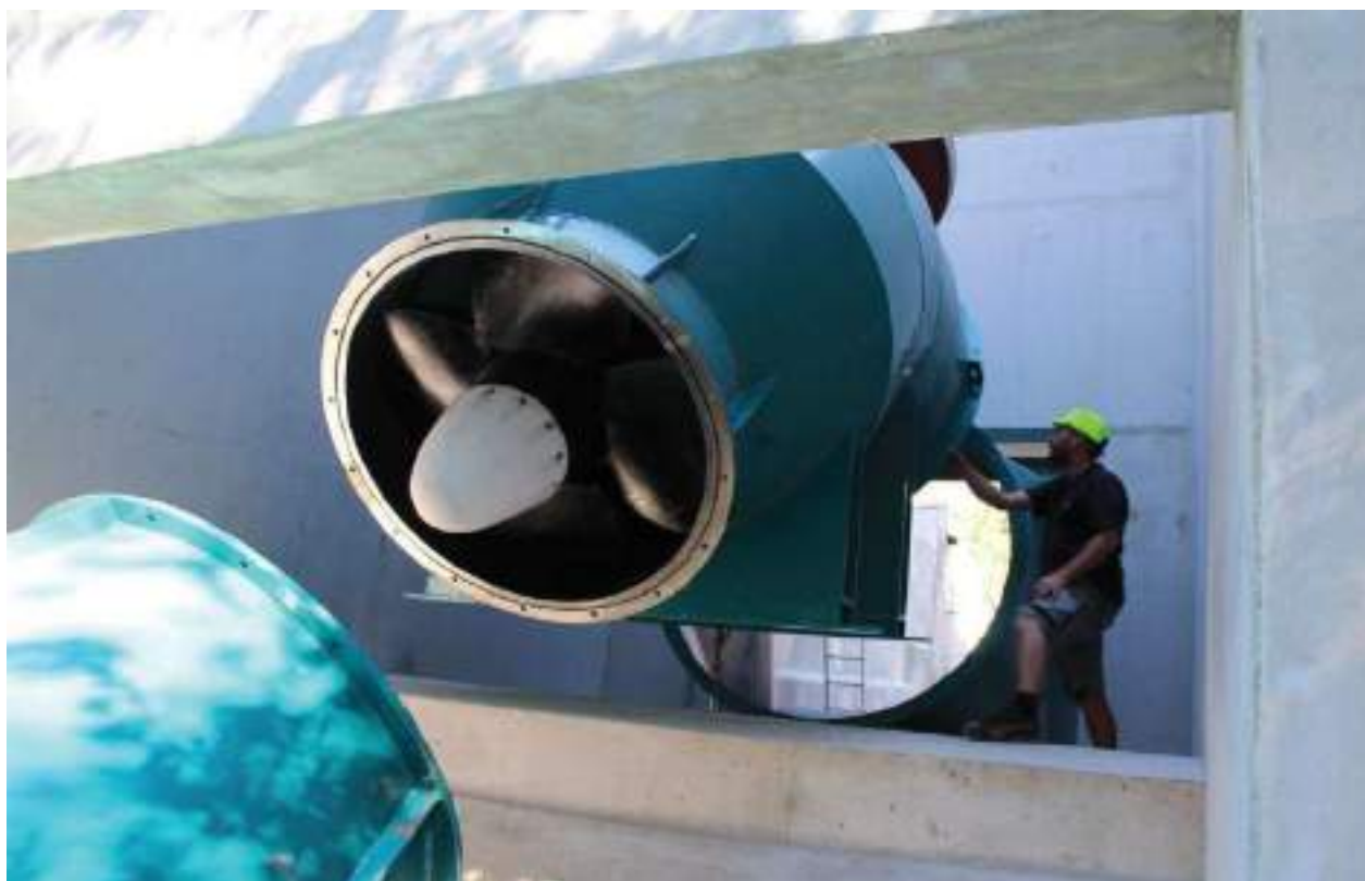
Centrale de Beire le Chatel – montage direct – 160kW, neuf - 2017
