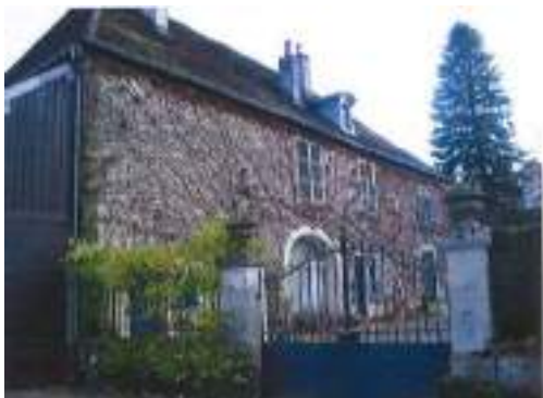
ELEMENT BATI N°2 : Demeure, leur mur, portail et parc : rue du Puits
