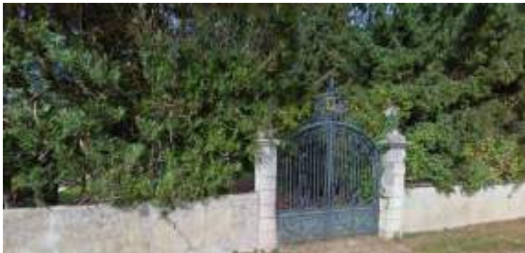
LINEAIRE A : Piliers de portail et muret en traversée de village : 10 Rue d
