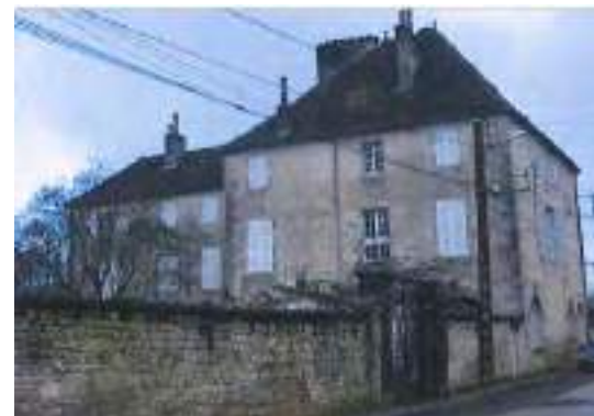
ELEMENT BATI N°19 : Demeure façade sud : rue du bas de la Fin/quartier du Port
