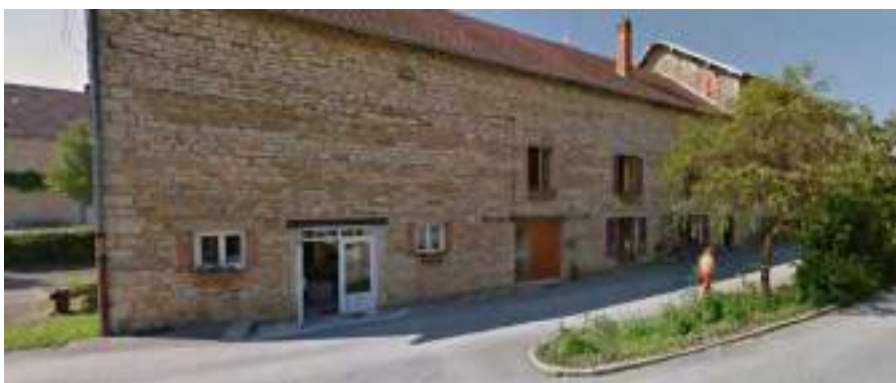
ELEMENT BATI N°4 : Moulin, minotterie : rue du Moulin
