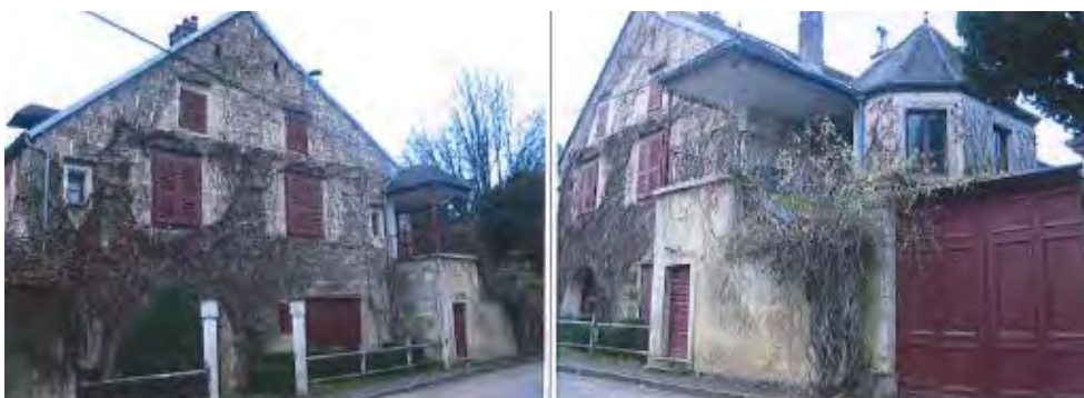
ELEMENT BATI N°23 : Demeure façade est sur rue et façade nord : rue du bas de la Fin/quartier du Port
