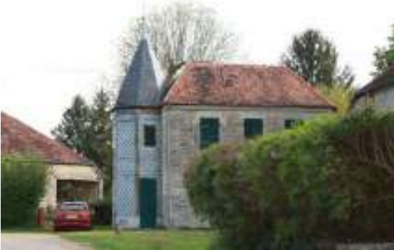
ELEMENT BATI N°2 : Ancienne minoterie : tour avec bardage métallique
