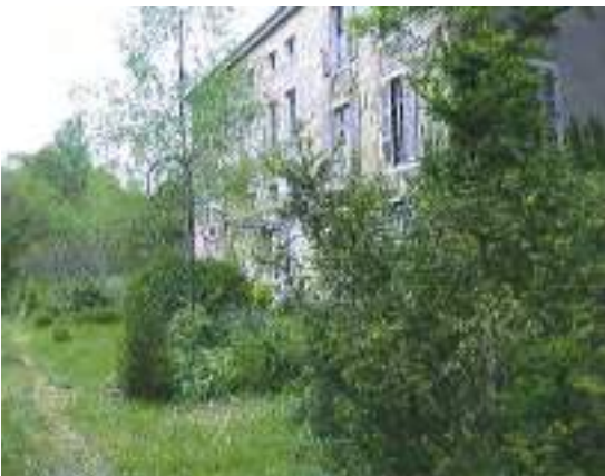
ELEMENT BATI N°7 : Demeure, dépendance, parc, mur et portail
