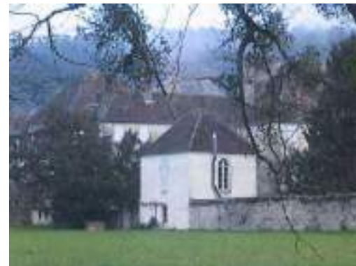
ELEMENT BATI N°18 : Façade Sud, pavillon : rue du bas de la Fin
