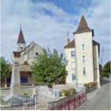
ELEMENT BATI N°1 : Mairie : façade, toiture : rue d
