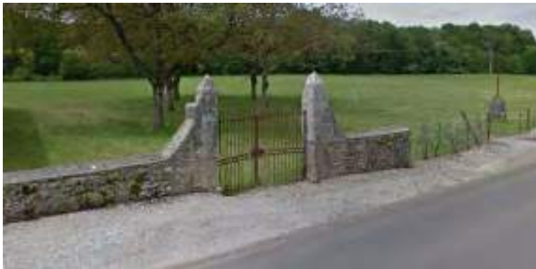
ELEMENT BATI N°2 : Piliers pierre et croix : à côté de la mairie
