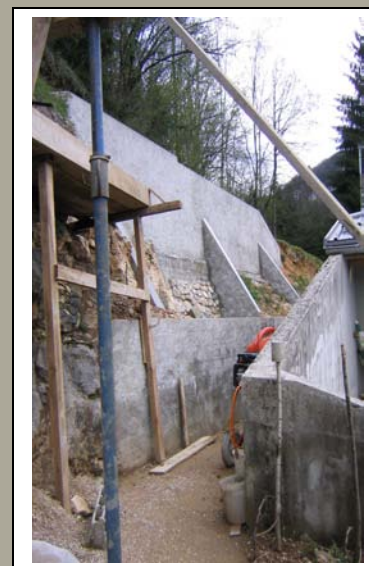
Figure 4 : Glissement et travaux de soutènement (hameau de Lizon)
