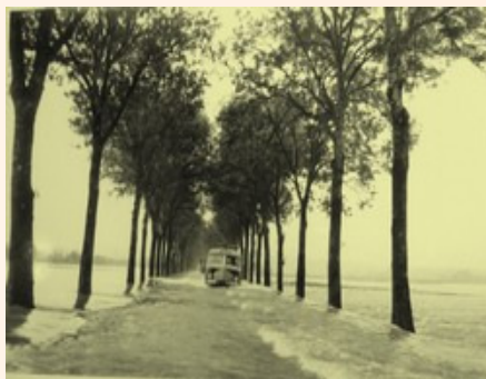
© Service hydraulique des Ponts et Chaussées, archives départementales du Jura : crue à Parcey, RN 5 en 1953.
