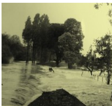
© Service hydraulique des Ponts et Chaussées, 1953, archives départementales du Jura : la rupture de la digue de Parcey en juin 1953.
