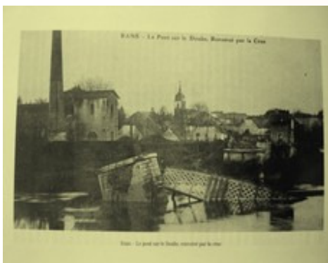
© Les forges de Rans, ouvrage, archives départementales du Jura : le pont sur le Doubs à Rans après la crue de 1910.
