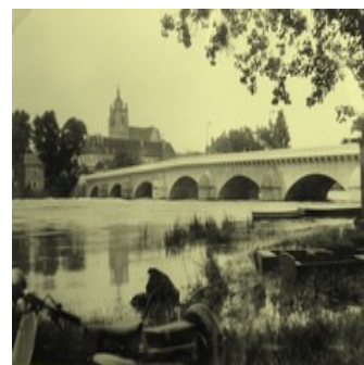
© Service hydraulique des Ponts et Chaussées, 1953, archives départementales du Jura : crue du Doubs, pont à Dole.
