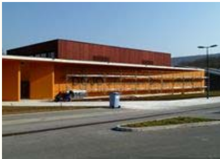
Sports et loisirs : infrastructures. © DDT du Jura, J. Culat.
