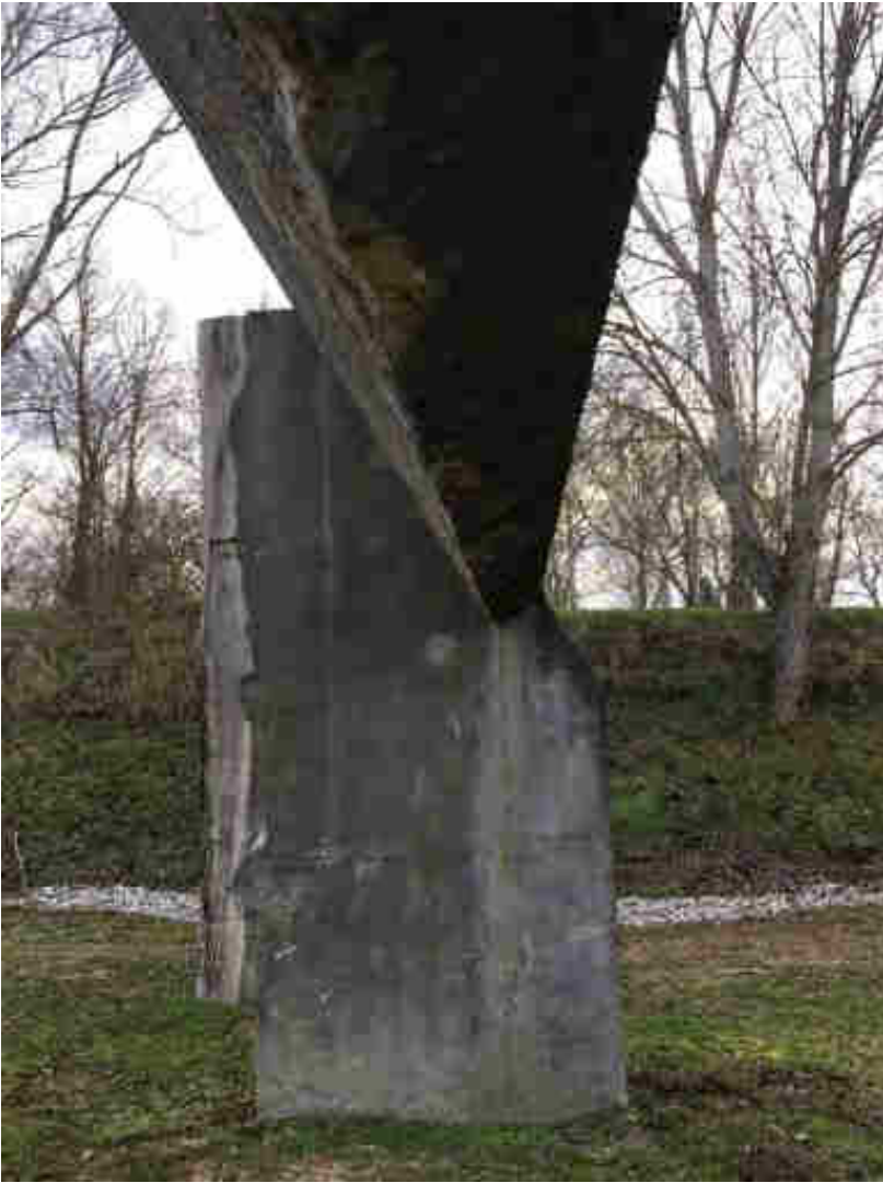
Pare balles : incliné, béton, fibrociment
