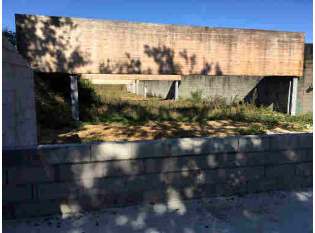
Pare balle bois plein sur stand 200m En cours de réalisation
