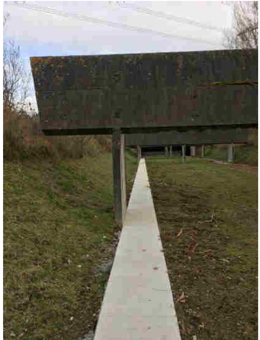
Pare balles : incliné, béton, fibrociment
