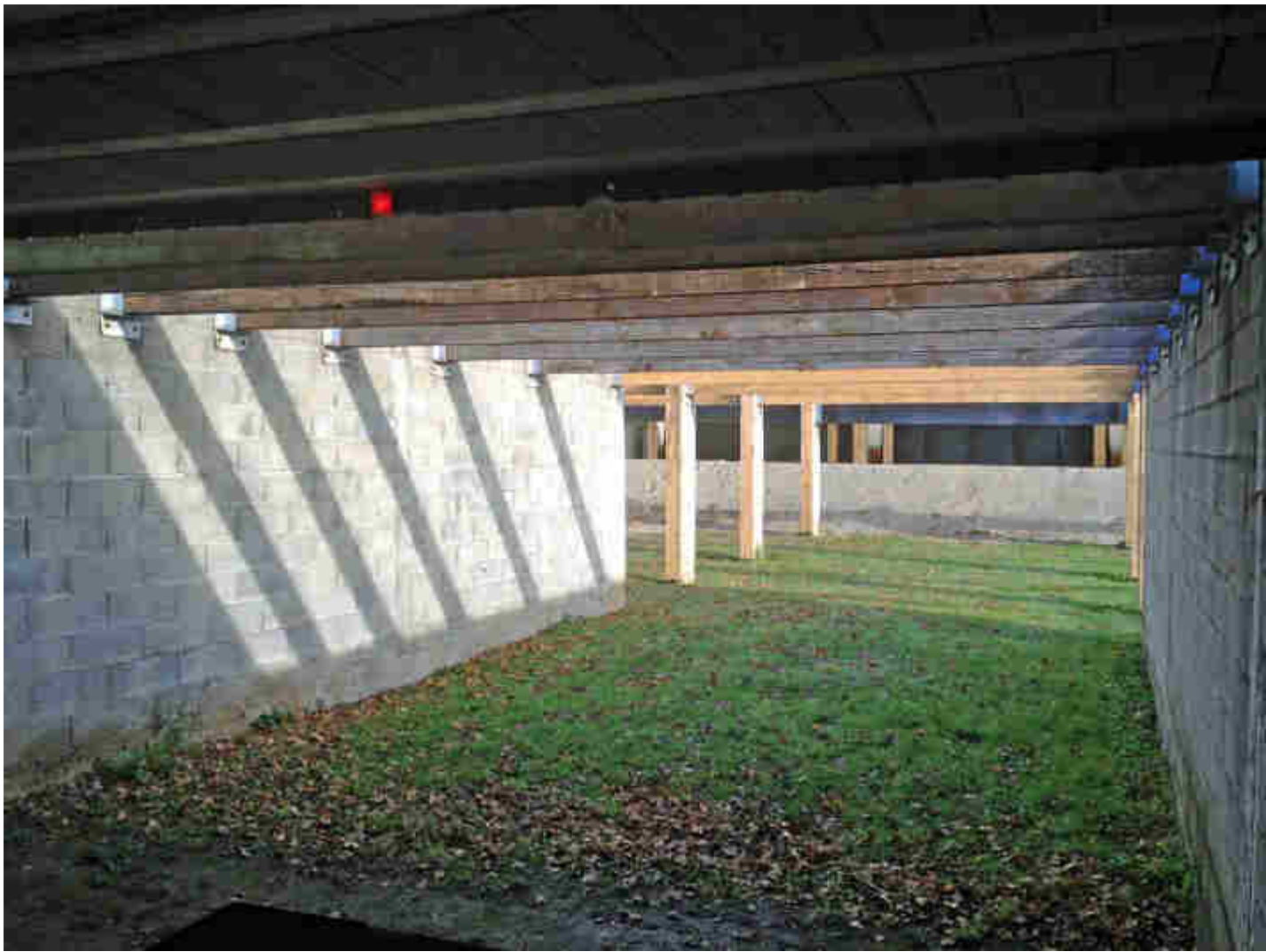
Casquette lames + pare balles La 22lr et les ogives chemisées traversent plusieurs lames de bastaing
