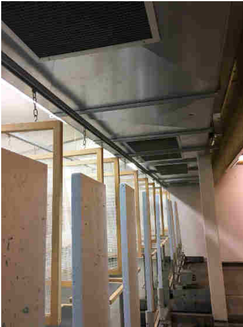
Autre système : aspirant (type cuisine) au dessus des pistolets
