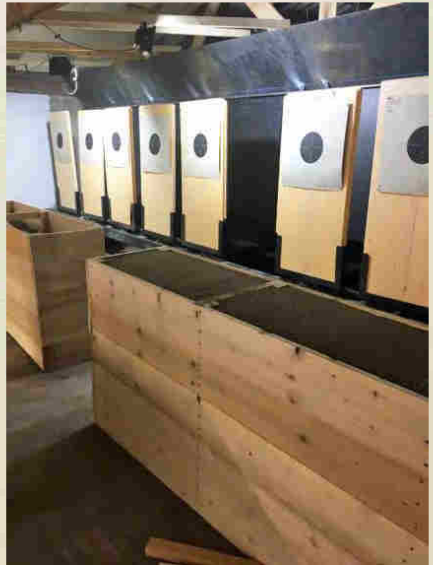
Coffres de protection de la ciblerie Rempli de sable
