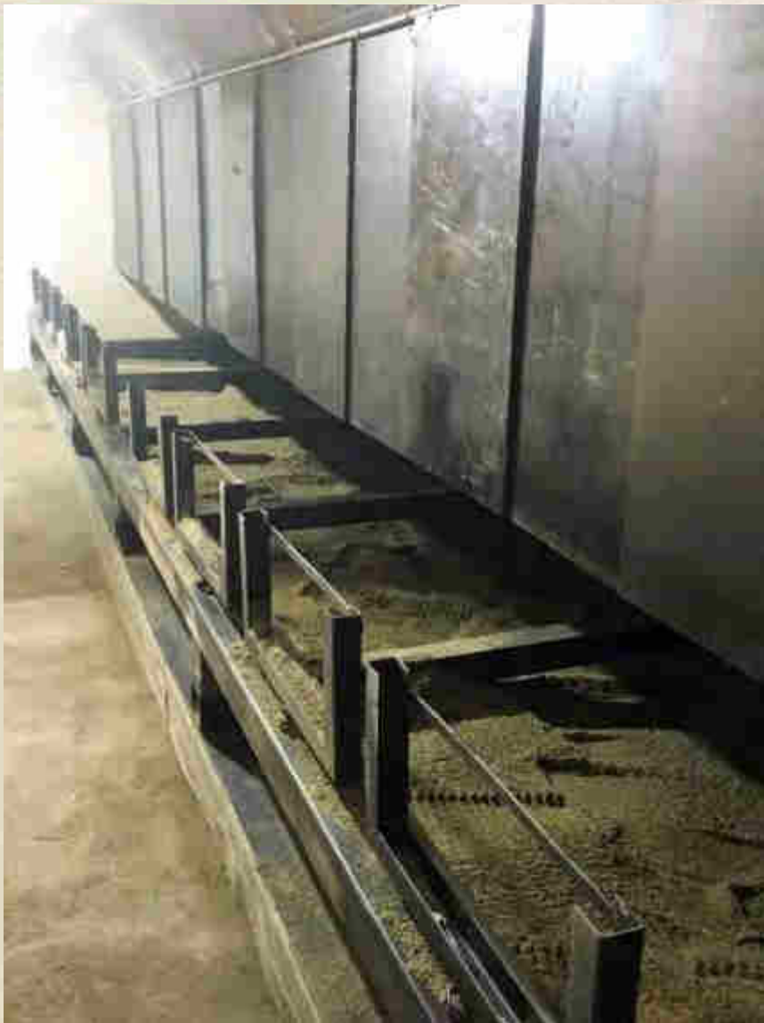
Mise en place « mur » anti retour Plaques téflon 2cm épaisseur Sable pour récupérer les plombs
