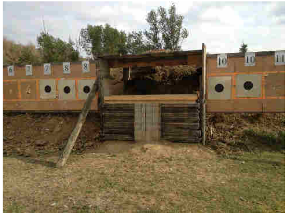
« Box » pour les gongs : les projections latérales sont « piégées »
