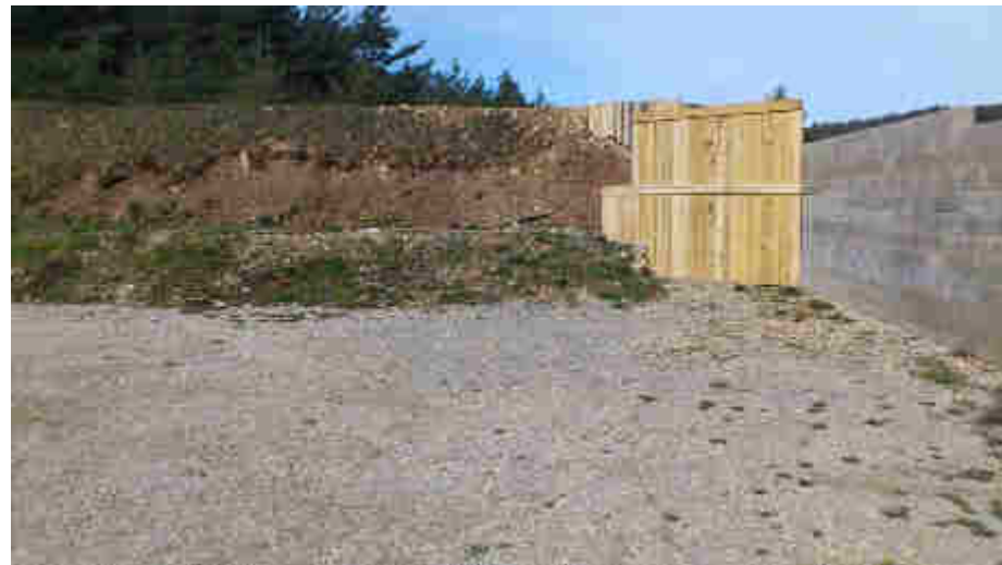
Mur bois cailloux supprimés
