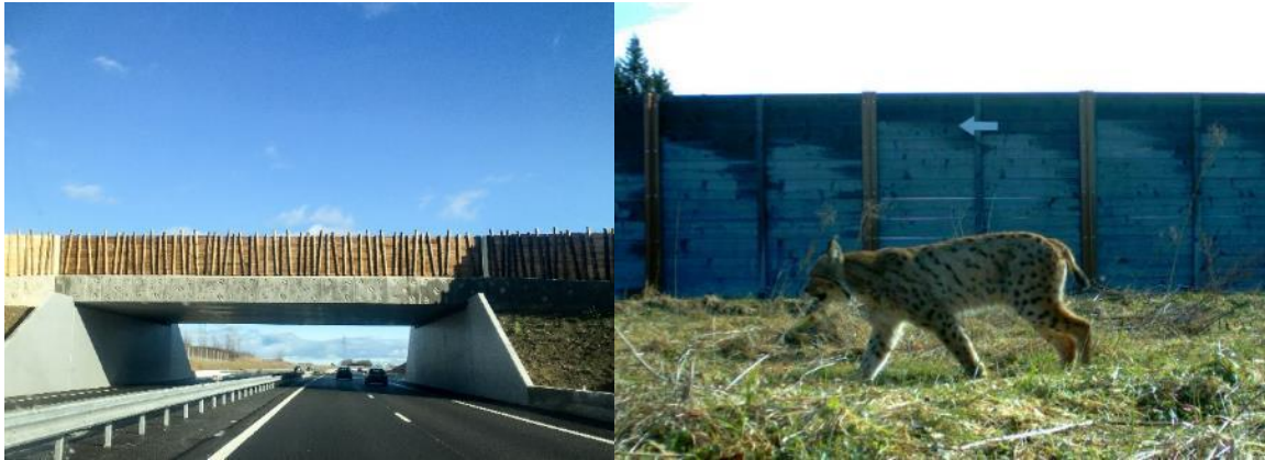
Exemple d'un passage à faune au-dessus d'une 2 x 2 voies (© OFB / S. Gatti). Les lynx peuvent utiliser ces passages à faune, et un engrellage adéquate doit permettre de canaliser les déplacements vers ces ouvrages pour un franchissement sécurisé des obstacles, ici dans le Doubs (© FDC25).
