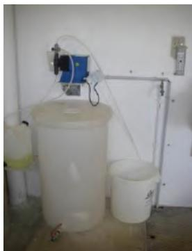
La station de traitement-refoulement de la Perrena se situe dans le hameau. L'eau arrive gravitairement depuis les sources. La bâche de stockage a un volume de 20 m<sup>3</sup>. Elle est chlorée dans la conduite de refoulement-distribution. Les 2 pompes (2,4-8 m<sup>3</sup>/h) fonctionnent en alternance pour refouler l'eau jusqu'au réservoir du hameau.
