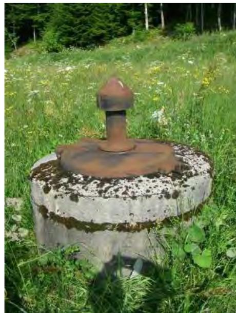
Le 13/01/2023 des traçages ont été réalisés afin de vérifier les connexions entre captages et avec l'adduction à la station de pompage. De la fluorescéine a été injectée (3,5 g) dans Perrena 4, le traceur apparaît ½ heure plus tard dans Perrena 3 et environ 1-2 heures plus tard dans la bache de la station de pompage au hameau. L'ouvrage Perrena 2 n'est pas concerné par ce traçage.
