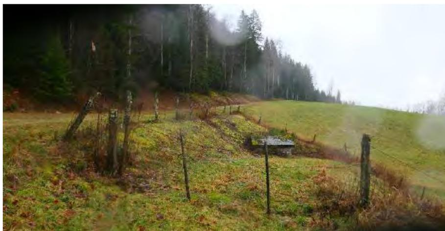
Un drain arrive de l'ouvrage Perrena 4. Une crépine coudée envoie l'eau vers un collecteur situé dans le vallon à l'aval du captage Perrena 1.
