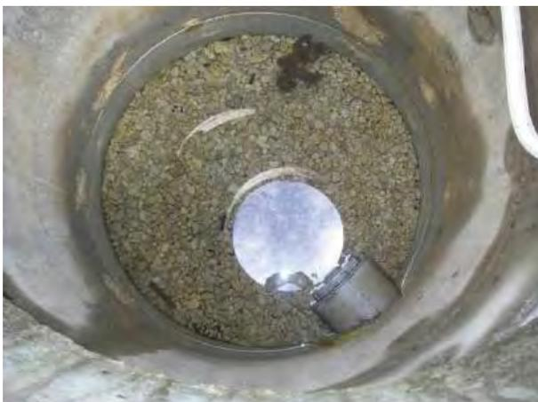
Ces ouvrages ne possèdent pas de trop-plein, ils alimentent en continu la bêche de la station de pompage en captant une nappe contenue dans des dépôts meubles : sables, graviers et éboulis.
