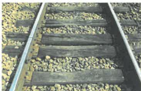
Rails courts sur traverses bois
