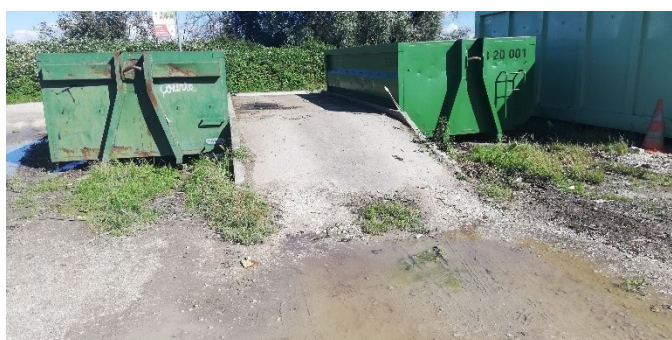
Figure 6 : Vue sur le petit ouvrage de génie civil permettant le vidage gravitaire des déchets verts
