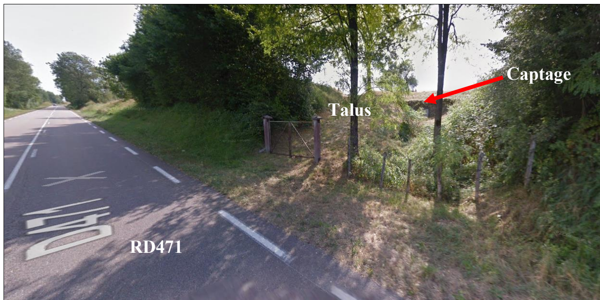
Figure 14 : Illustration photographique du captage de la SNCF (source : Google Map)
