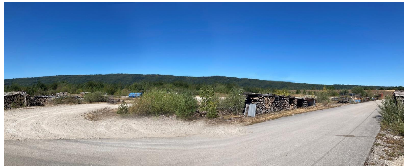
Figure 26 : vue initiale depuis l'angle sud-est du parc photovoltaïque
