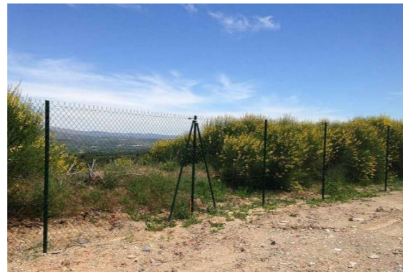
Figure 8 : Exemple de clôture d'enceinte d'une centrale solaire photovoltaïque
