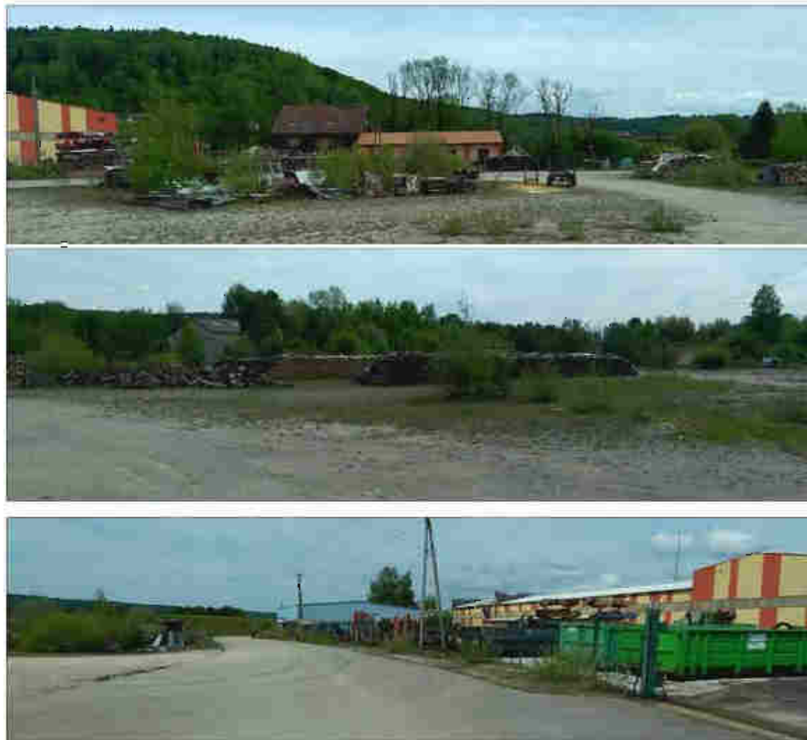
Figure 19 : Illustrations photographiques de la plateforme et de la voirie, observées le 10/05/2022
