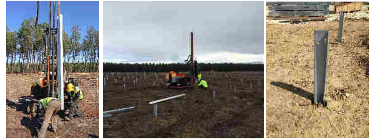
Figure 22 : Exemples de mise en place des pieux battus sur les chantiers URBASOLAR
