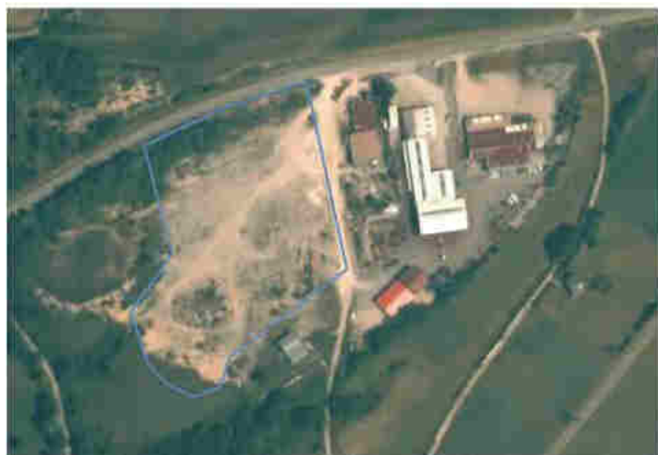
Figure 20 : Vue aérienne en 2006
