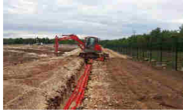
Figure 21 : Exemple d'enfouissement de câbles électriques
