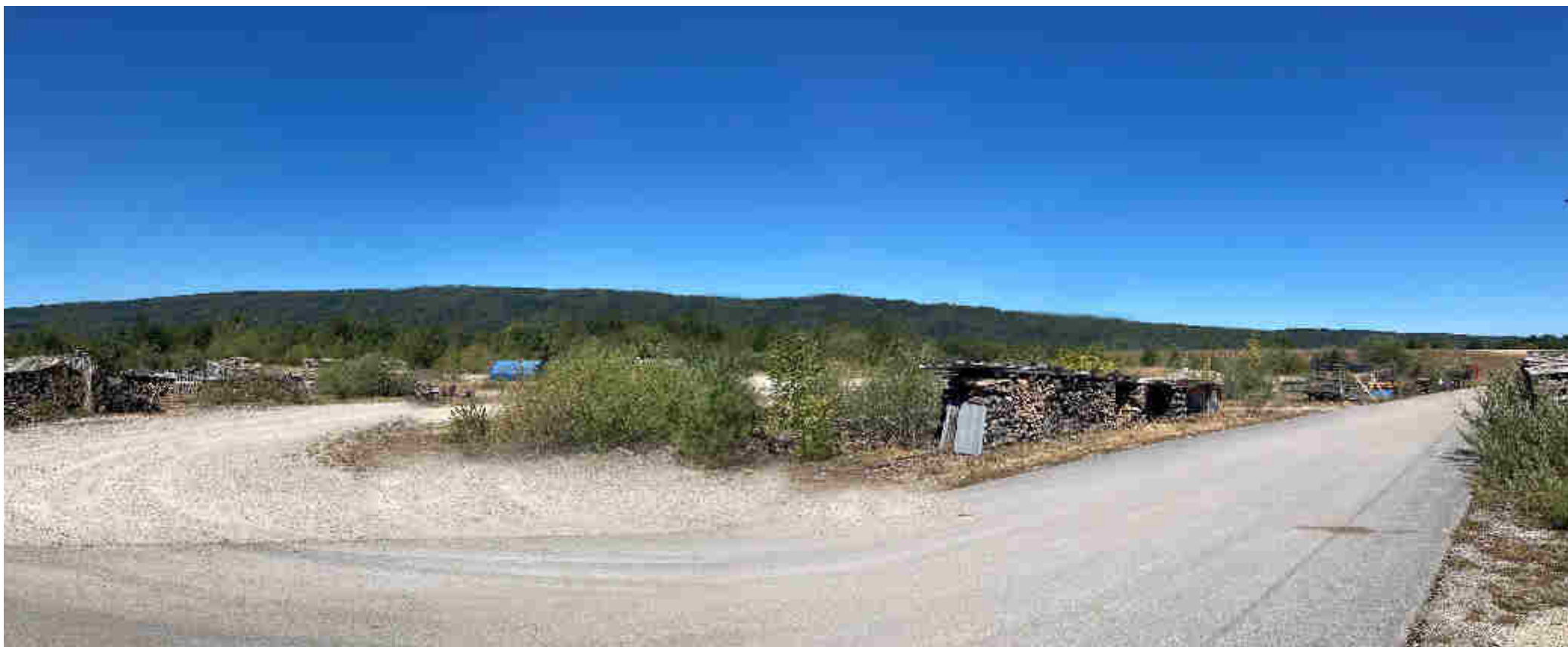
Figure 126 : vue initiale depuis l'angle sud-est du parc photovoltaïque
