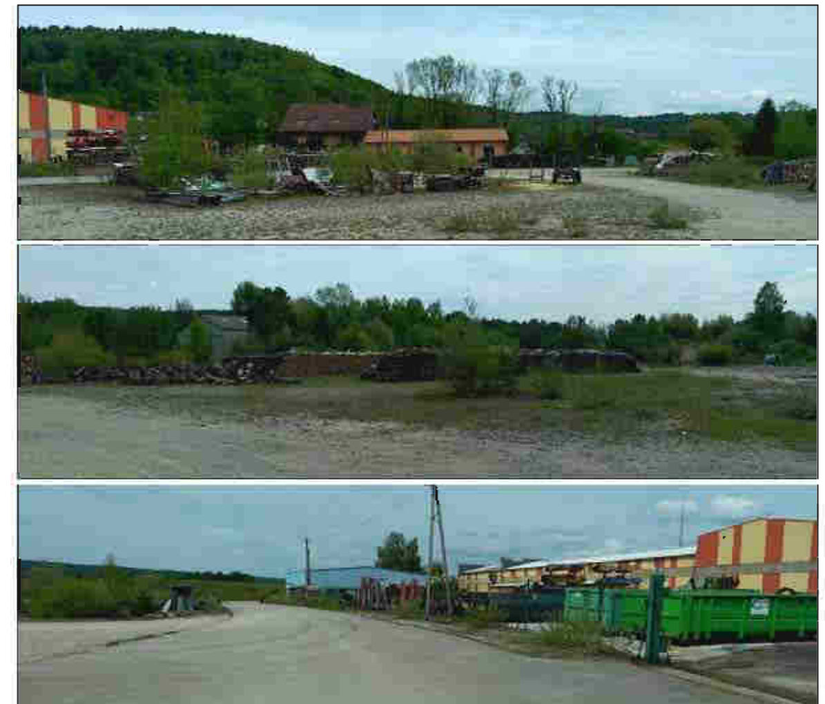
Figure 6 : Illustrations photographiques de la plateforme et de la voirie, observées le 10/05/2022
