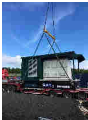
Figure 25 : Livraison d'un poste électrique
