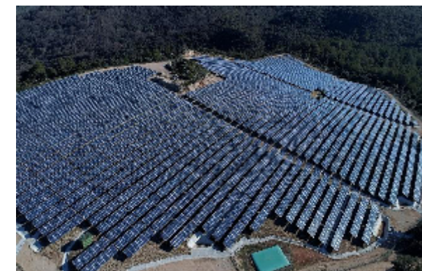
3,8 MWc Parc solaire La Tour sur Orb (34) – Foncier communal Développement, Financement, Construction et Exploitation Ancienne mine de bauxite
