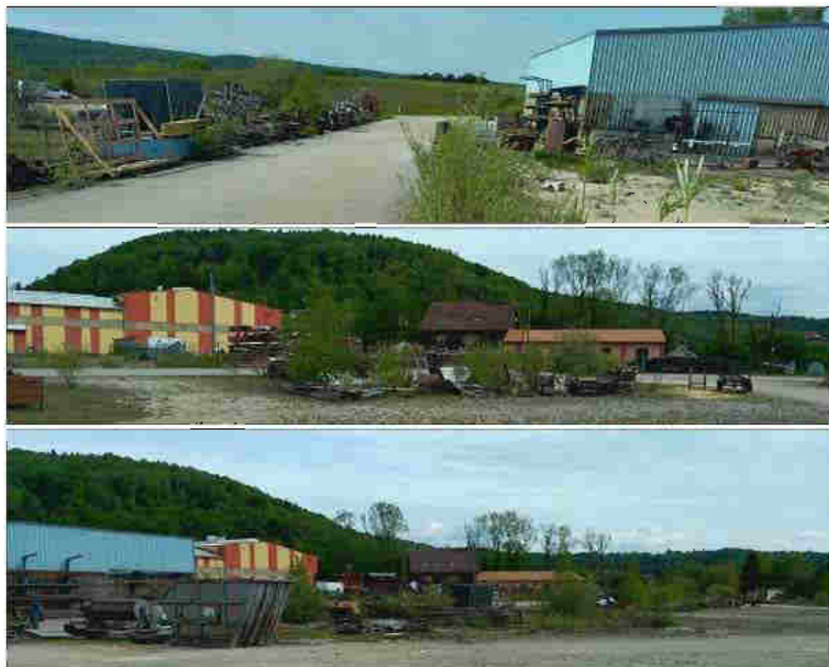
Figure 32 : Illustrations photographiques des éléments métalliques, observés le 10/05/2022
