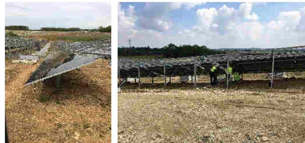
Figure 24 : Exemples de mise en place de panneaux sur les chantiers URBASOLAR
