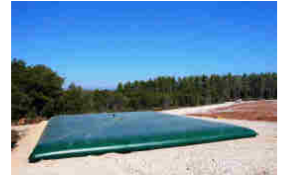
Figure 16 : Photographie d'une citerne
