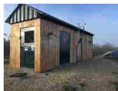
Figure 26 : Exemple de local en bardage bois
