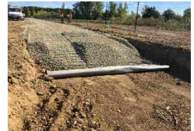
Figure 20 : Exemple de réalisation de voie d'accès interne
