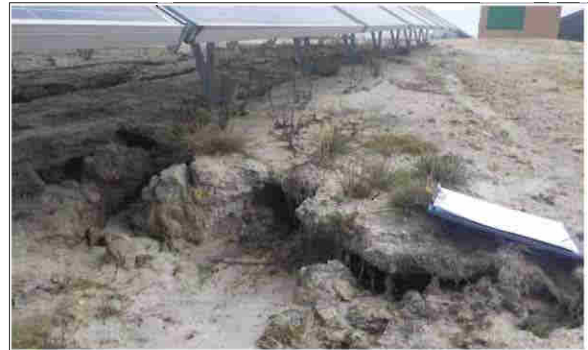
Figure 25 : Exemple photographique du phénomène d'érosion en pied de panneaux, en l'absence de végétation sur un sous-sol sablo-graveleux (source : PHREALOG)
