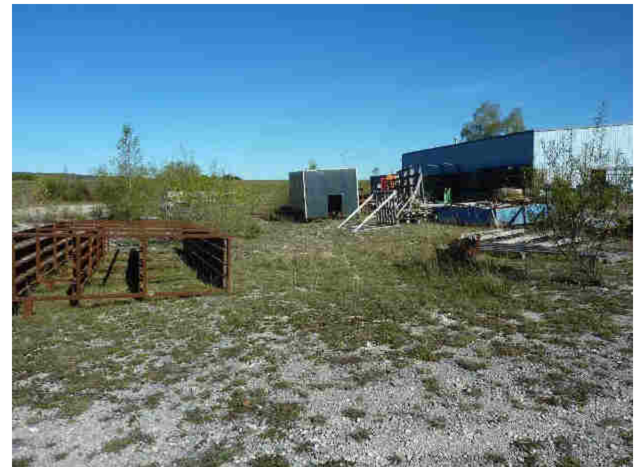
Figure 122 : Dépôts divers au sein de la zone d'implantation retenue pour le projet
