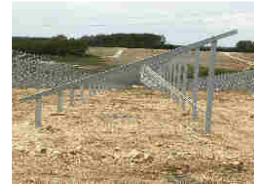
Figure 23 : Exemple d'une structure porteuse complète avant mise en place des panneaux
