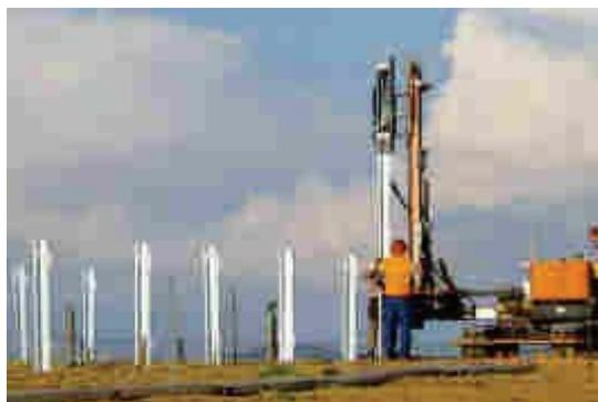
Figure 4 : Exemple de batteuse hydraulique
