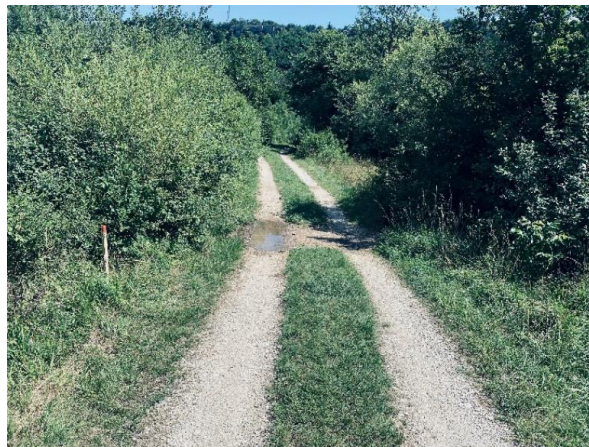
Figure 17 : Piste à créer pour éviter la circulation dans le hameau de Vouglans
