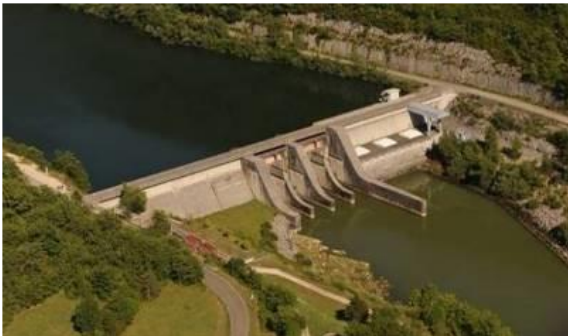
Figure 7 : Vue aérienne de l'aménagement de Coiselet
