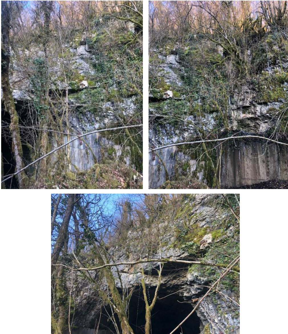
Figure 30 : Vues de la falaise en sortie de la galerie de dérivation
