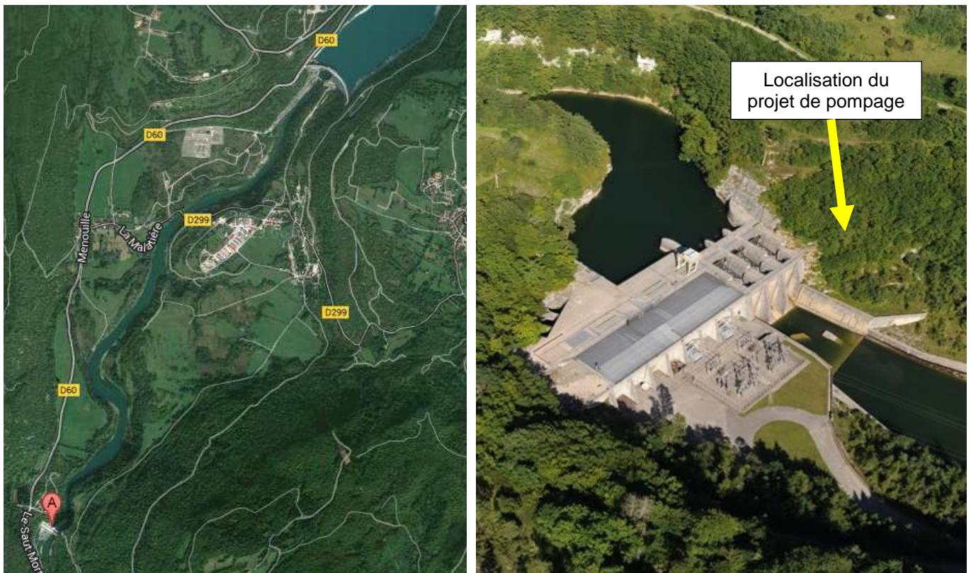
Figure 4 : Plan de localisation du barrage de Saut-Mortier (à gauche) et vue aérienne du barrage de Saut-Mortier (à droite)
