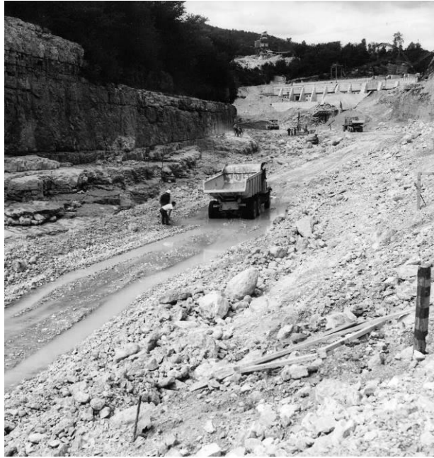
Figure 239 : Travaux de terrassement lors de la construction du barrage de Saut Mortier
